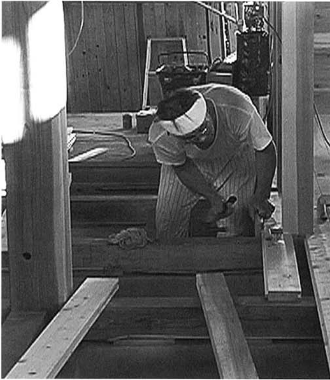
現場で木材を見比べながらの作業。 昨今の大工仕事ではあまり見かけなくなった光景
